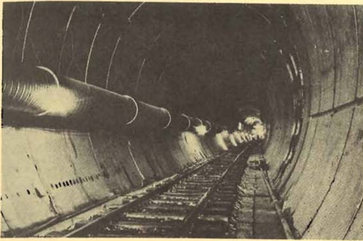
北迴鐵路大隧道
